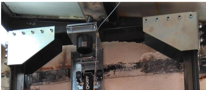
Appuyer le tube sur l'extrémité des guides ; les deux extrémités doivent être coupées au même niveau pour assurer le bon appui du tube. Assembler l'ensemble constitué du tube et des équerres ainsi que les platines d'assemblage des équerres à chacun des guides.
